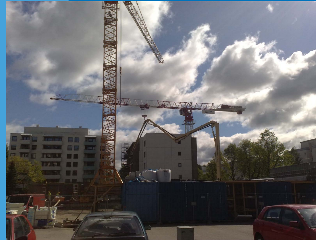
Kortepohjan pysäkin rakennustyömaa
